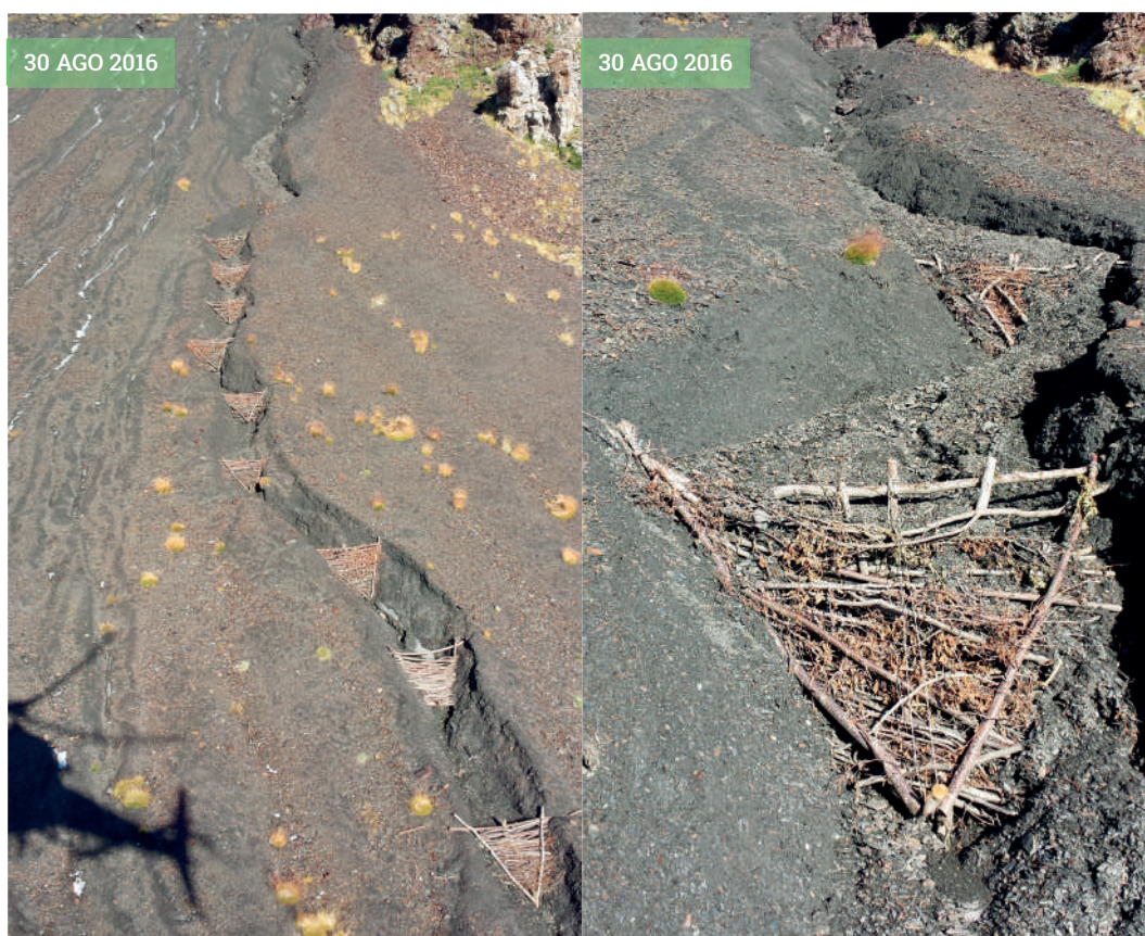
Figura 5: A izquierda cárcava con microdiques recién construidos, obsérvese el suavizado cóncavo de la cárcava por pisoteo del ganado. A derecha retención de las primeras lavas torrenciales, obsérvese las paredes verticales y el cordón de desbordamiento que se forman al paso de las lavas.
