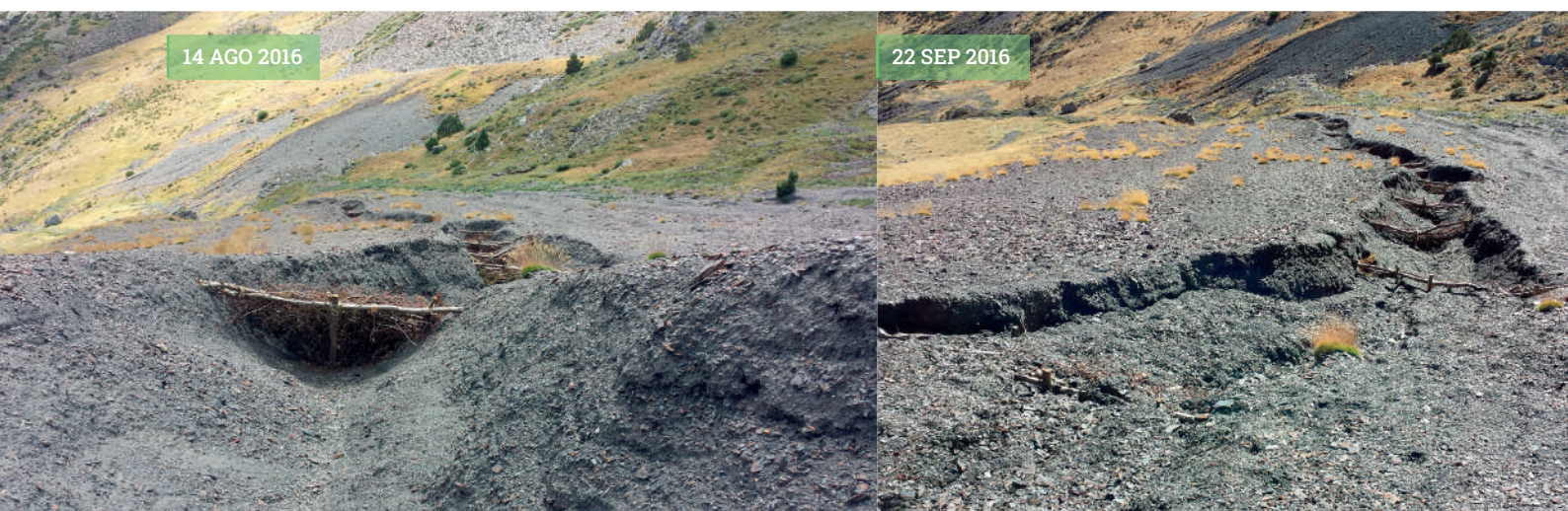
Figura 6: A izquierda cárcava con microdiques recién construidos, obsérvese el suavizado cóncavo de la cárcava por pisoteo del ganado. A derecha retención de las primeras lavas torrenciales, obsérvese las paredes verticales y el cordón de desbordamiento que se forman al paso de las lavas.
